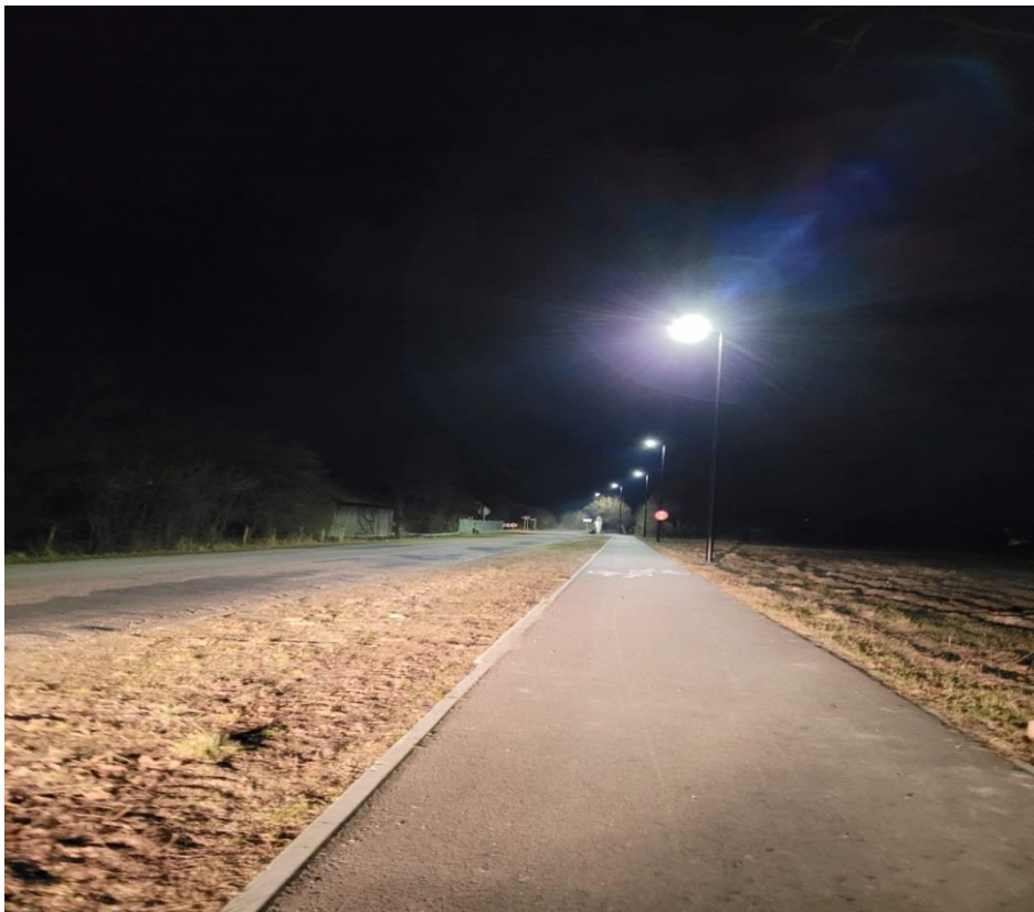
Budowa oświetlenia na „Szlaku Wojennym” w miejscowości Wytyczno
