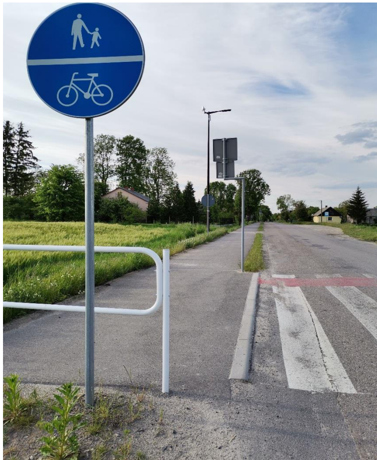
Budowa ciągu pieszo – rowerowego
