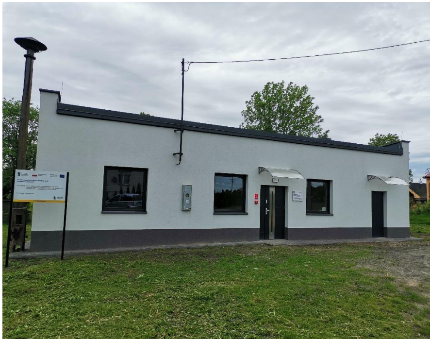
Świetlica wiejska w Wólce Wytyckiej
