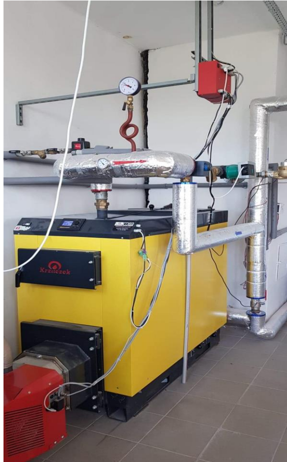
System ogrzewania- piec na pellet w Szkole Podstawowej w Wytycznie
