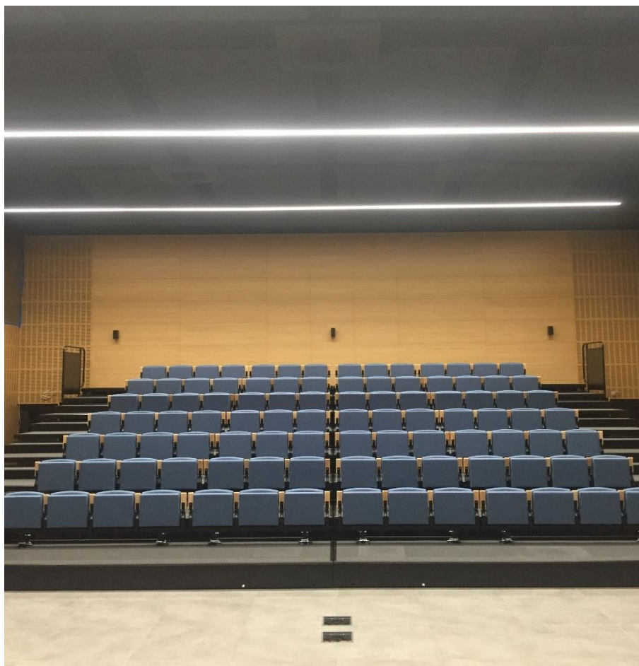
Sala widowiskowo- koncertowa w trakcie realizacji
