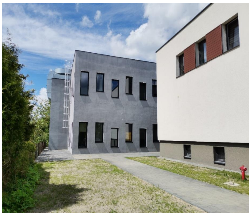
Przebudowa i rozbudowa GBP Urszulin- w trakcie realizacji
