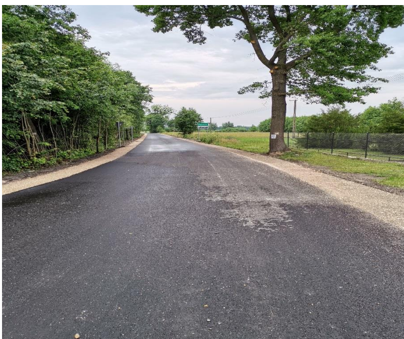
Droga gminna w Dębowcu
