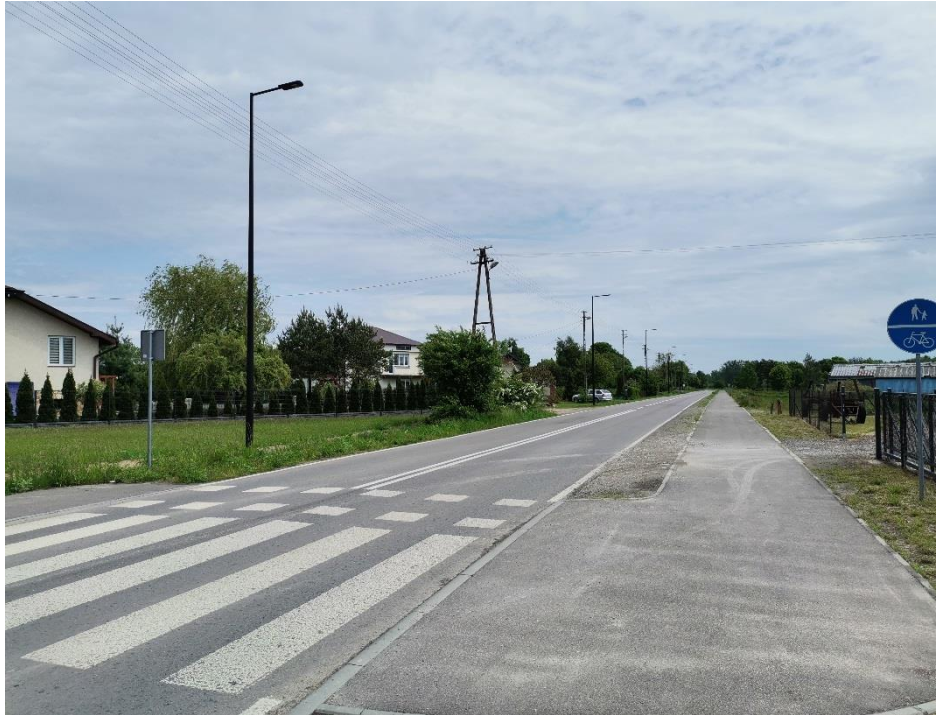
Budowa oświetlenia ul. Pocztowa
