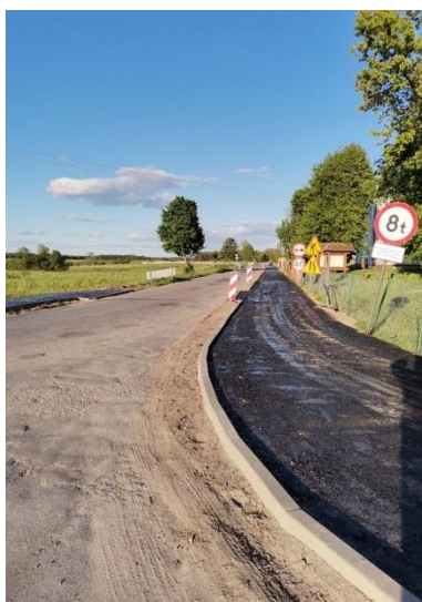
Budowa ciągu pieszo- rowerowego w msc. Wola Wereszczyńska
