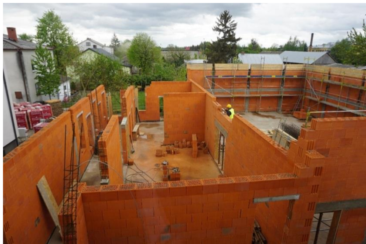
Przebudowa i rozbudowa GBP Urszulin- w trakcie realizacji
